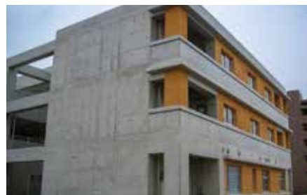
コンクリート壁
