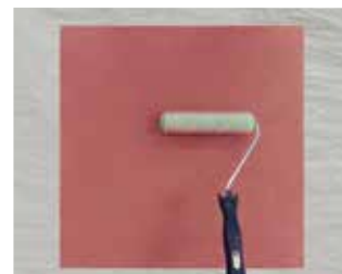
ローラー均し
